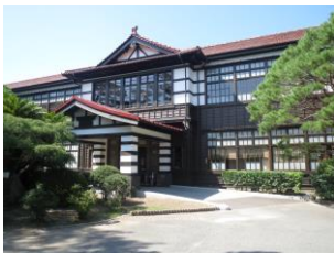
明倫小学校旧本館
